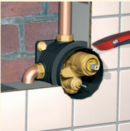
4. Ablängen des Elastomere-Mantels einfach mit Cutter oder Schere.
